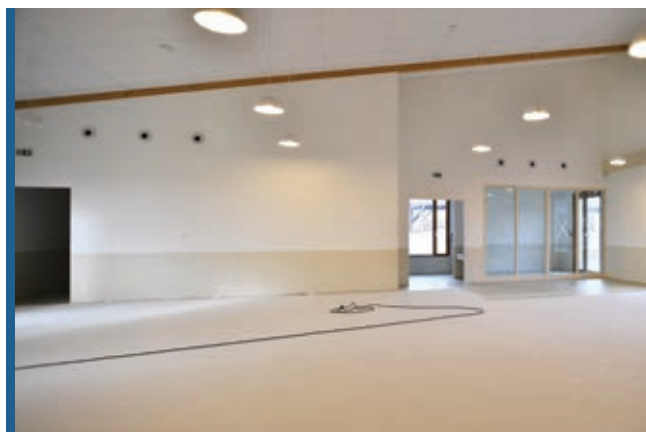
Salle de la cantine en cours d'aménagement
