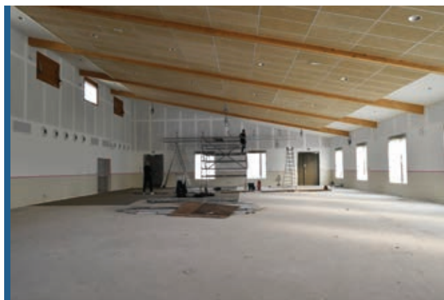
Salle principale de l'Espace Chérois en cours d'aménagement
