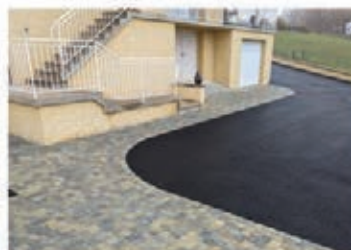
Réalisation d'une cour en pavés et enrobé
