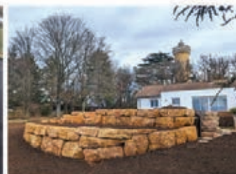
Enrochements en terrasses pour aménagement terrain
